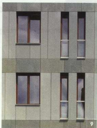
8. Fragment elewacji południowo-wschodniej budynku A
